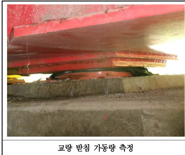
【사진 4.3.35】 교량받침 이동량 측정
