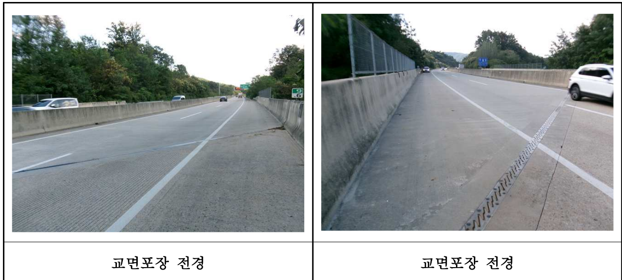
【사진 4.3.39】 교면포장 전경
