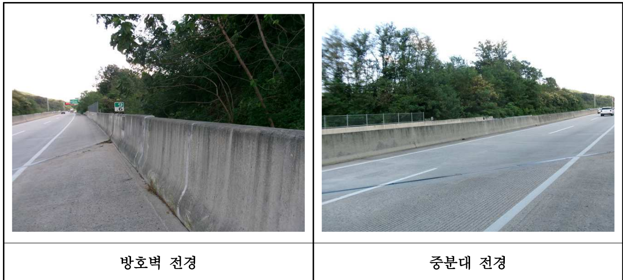
【사진 4.3.43】 방호벽 및 중앙분리대 전경
