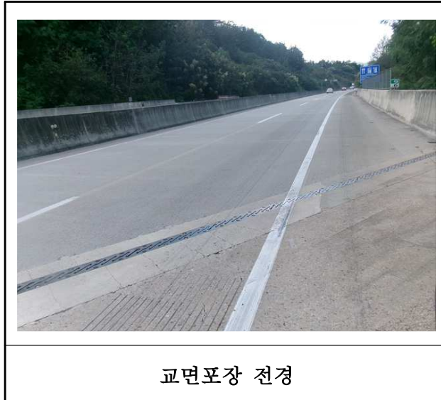
【사진 4.3.17】 교면포장 전경
