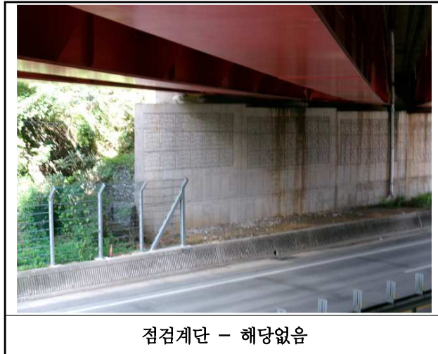
【사진 4.3.45】 교량 점검시설 전경
