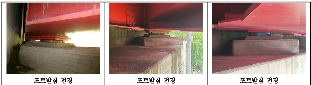
【사진 4.3.10】 교량받침 전경
