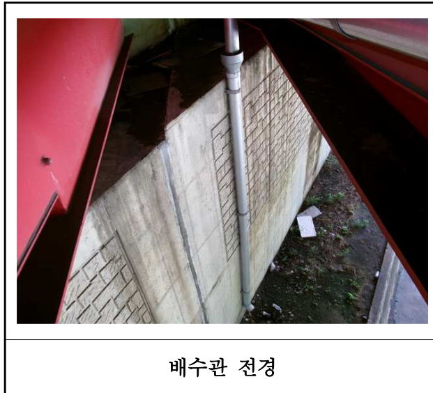
【사진 4.3.19】 배수시설 전경
