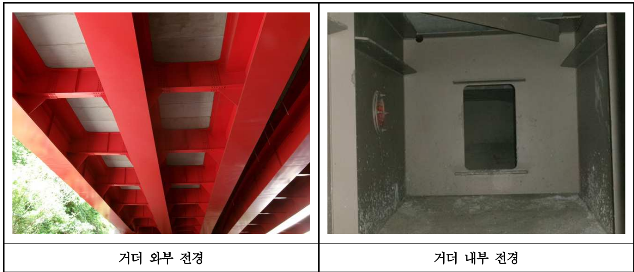
【사진 4.3.26】 거더 전경
