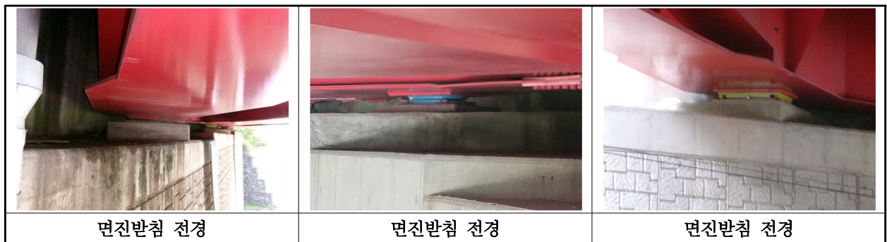
【사진 4.3.32】 교량받침 전경
