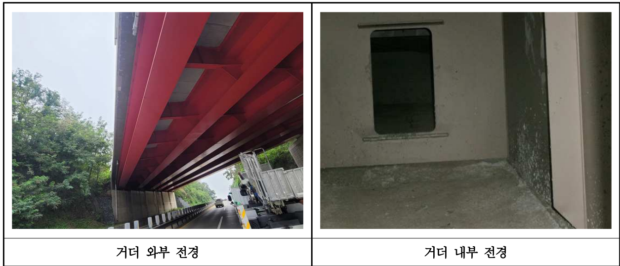
【사진 4.3.4】 거더 전경
