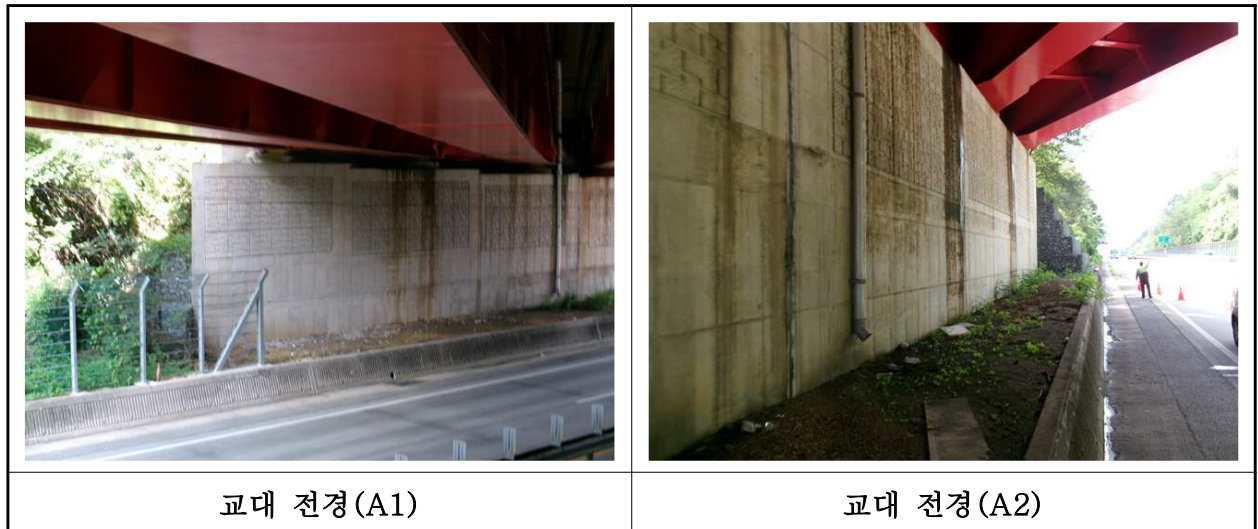
【사진 4.3.30】 교대 전경
